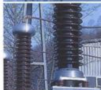
OE 1.145-04 Маслонаполненная концевая муфта с фарфоровым изолятором для наружной установки и подсоединения к воздушным линиям.
